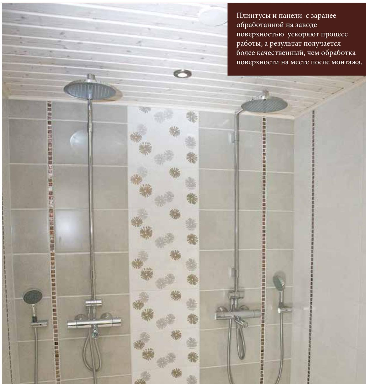
Плинтусы и панели с заранее обработанной на заводе поверхностью ускоряют процесс работы, а результат получается более качественный, чем обработка поверхности на месте после монтажа.
